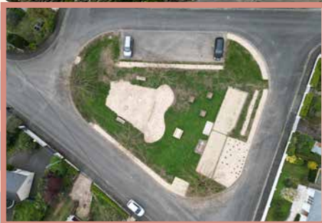
Un chantier rondement mené
