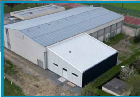
La fin d'un chantier semé d'embûches
